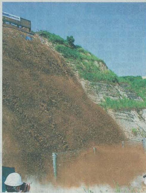
実験で効果を確認した、流下する土砂を受け止めるHEP工法の柵 —高岡市岩坪
